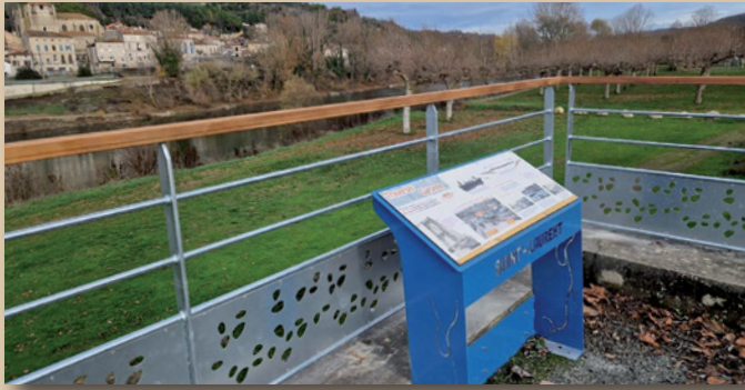
Rambarde de l'ancien pont
